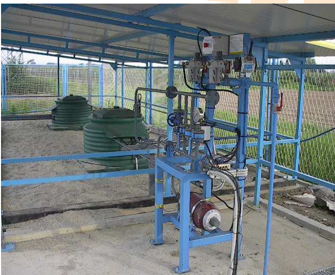
Skid per il Controllo della Pressione del Pentano.
