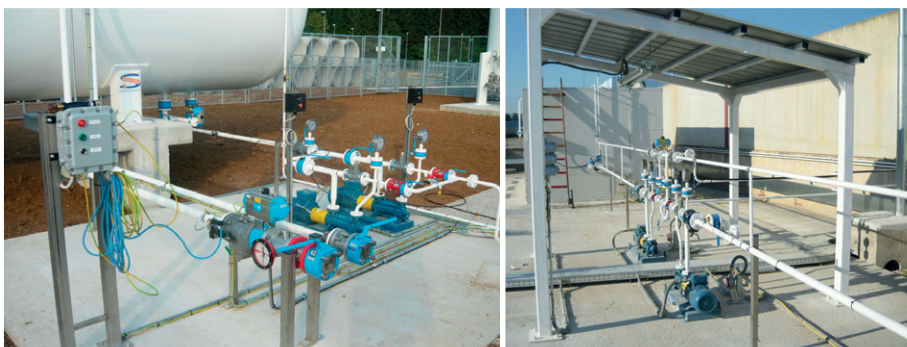
Gruppo pompe gas espandente alla produzione (bassa pressione). Pumps group for blowing agent gases (low pressure).
