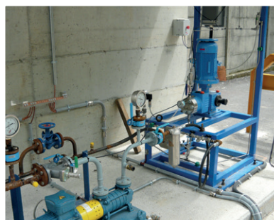
Sistemi pompa di alta pressione per dosaggio agenti espandenti. Agent foam high pressure pump system.
