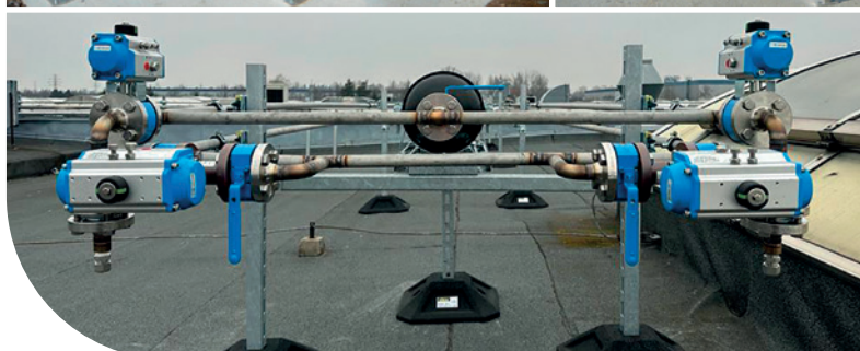
Gruppo/i di blocco gas refrigeranti e sistema di sicurezza attiva e passiva per gas refrigeranti infiammabili.
